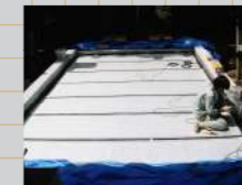
▲ 神門手前の石畳部分にCFボードヒーターを埋設
