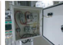
融雪制御盤 (電気容量により別製作)
