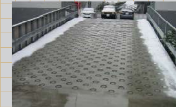
《マンション出入口のスロープ》 ▲ スロープ部分にCFボードヒーターを埋設 (新潟県)
