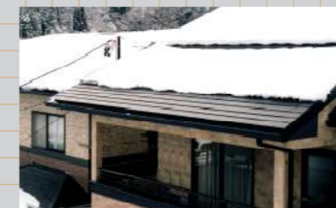
▲軒先部分施工の効果
