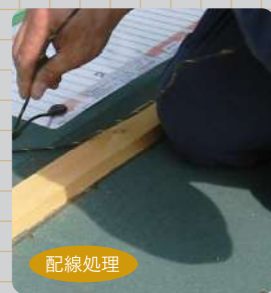
配線処理・コーキング (写真は落し込みの場合)
