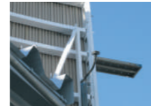
降雪センサー(壁面取付例)
