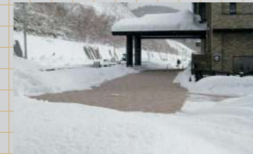
▲ 摺上川ダム (福島県)
