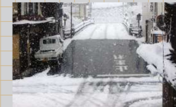
《既存街路上へ1日で表層まで施工》 ▲ 桁形橋 西詰街路 (岐阜県高山市)
