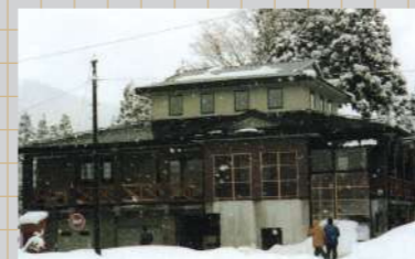
▲降雪中でもCFボードヒーター設置箇所はほとんど積雪がない (新潟県)
