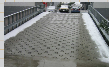
《マンション出入口のスロープ》 ▲スロープ部分にCFボードヒーターを埋設 (新潟県)
