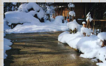
▲CFボードヒーターを埋設した 250mmの石面もきれいに消雪 (山形県)
