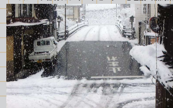
《既存街路上へ1日で表層まで施工》 ▲拱形橋 西詰街路 (岐阜県高山市)
