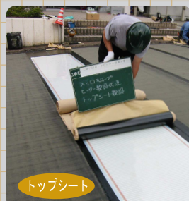
さらにトップシートを貼り込む。 (温度センサーを設置)
