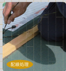
配線処理・コーキング (写真は落し込みの場合)
