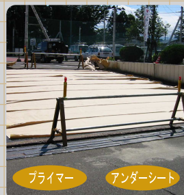
路盤(下地)にプライマーを塗布後に アンダーシートを敷設する。
