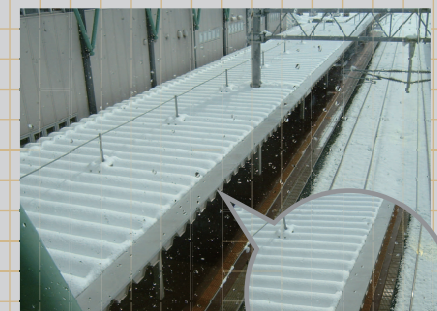
▲ 降雪中でもCFボードヒーター設置箇所はほとんど積雪がない
