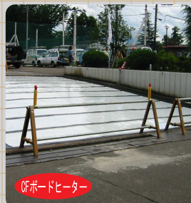
その上にCFボードヒーターを貼り込む。
