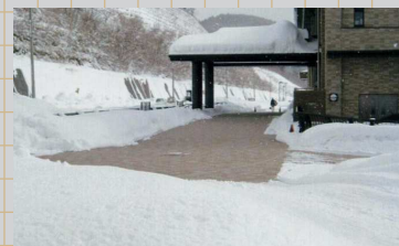
▲ 摺上川ダム (福島県)
