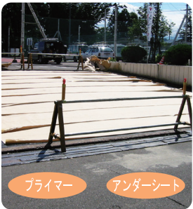
路盤(下地)にプライマーを塗布後にアンダーシートを敷設する。
