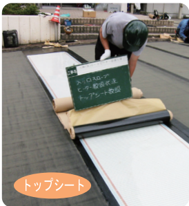
さらにトップシートを貼り込む。(温度センサーを設置)
