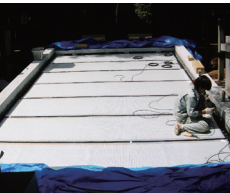
▲神門手前の石畳部分にCFボードヒーターを埋設
