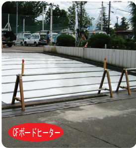
その上にCFボードヒーターを貼り込む。
