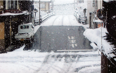
《既存街路上へ1日で表層まで施工》 ▲枅形橋 西詰街路 (岐阜県高山市)
